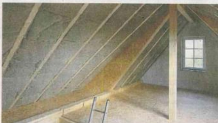
Mit Matten aus Hanffasern können Mauern und Dächertüble von Häusern ökologisch gedämmt werden.
